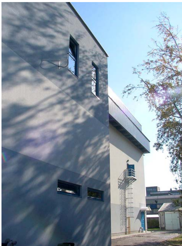
Erőmű főépület a hangszigetelő fallal a tetőrészen
