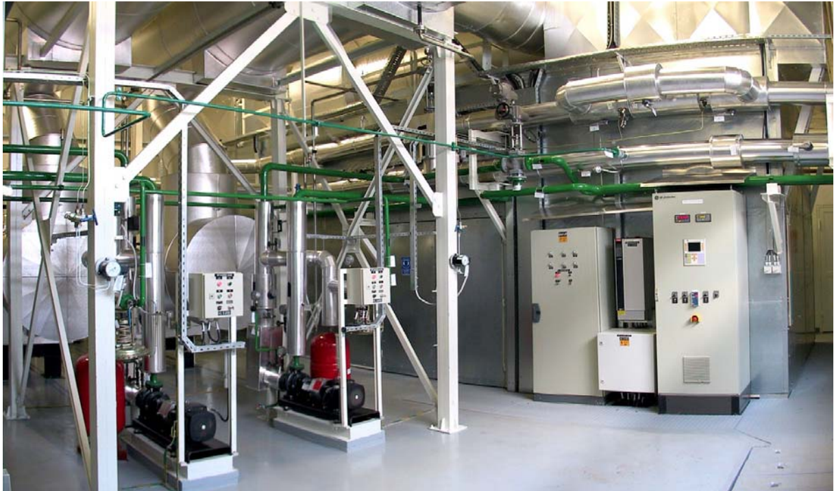
Technológiai tér a hangtompítókkal (fent) és a füstgáz-víz hőcserélőkkel (alul), a háttérben a gázmotorcella
