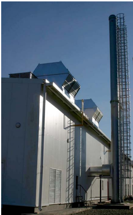
Gázmotoros bővítés csarnoképület
